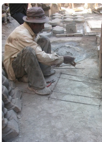
Um pedreiro local faz lajes de latrinas em Antananarivo.
