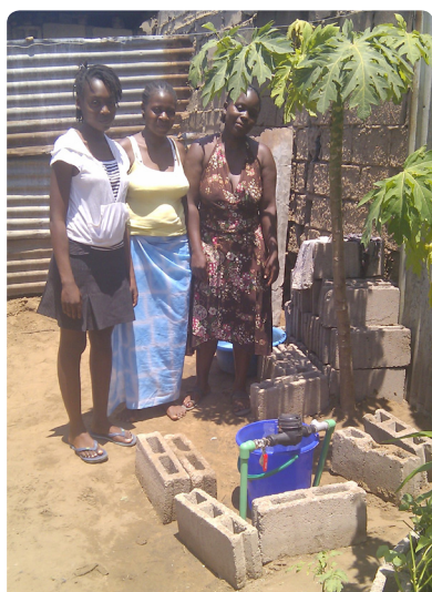
Un branchement domestique à Maputo
