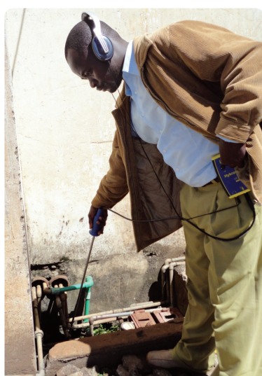
Localisation de fuites
